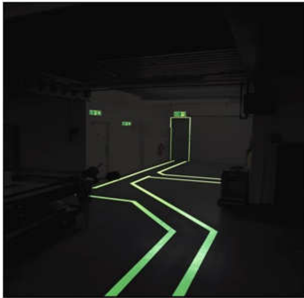
Afbeelding 4H: Fotoluminescerende vluchtrouteaanduiding
